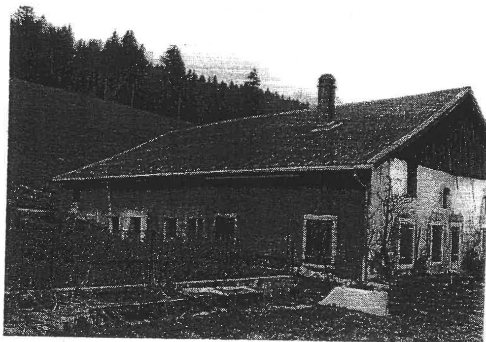
Toiture recouverte de plaques ondulées "Eternit"
