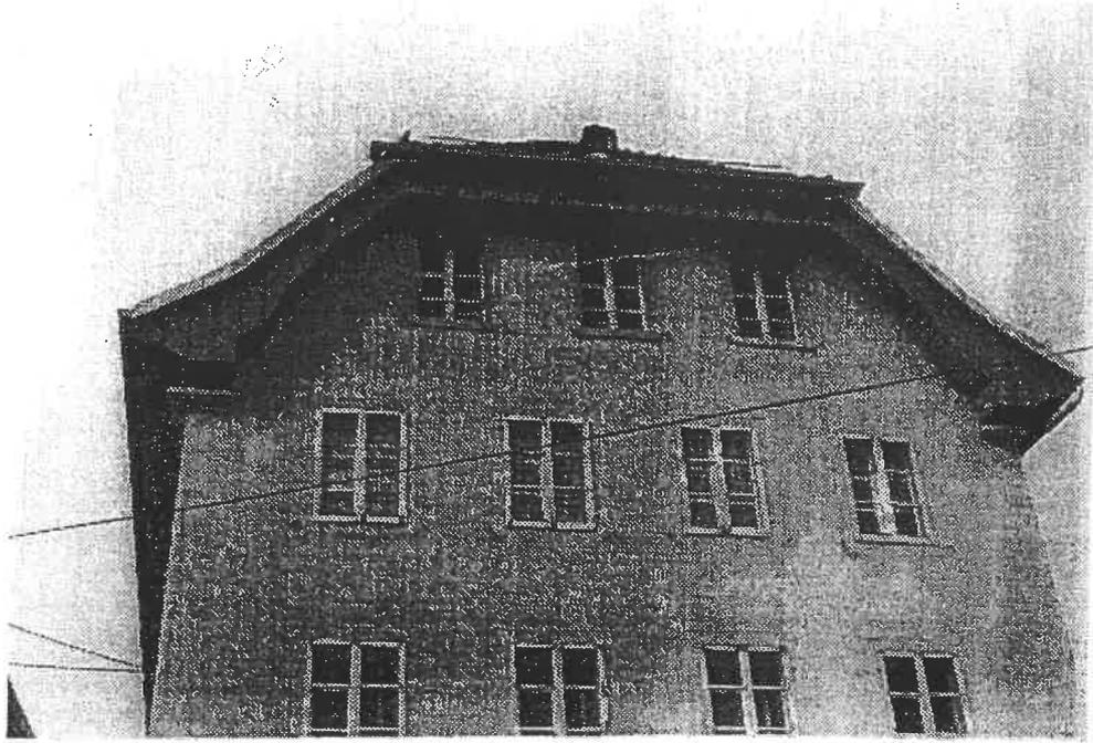
Avant-toit lambrissé en lames de bols larges avec baguette de recouvrement
