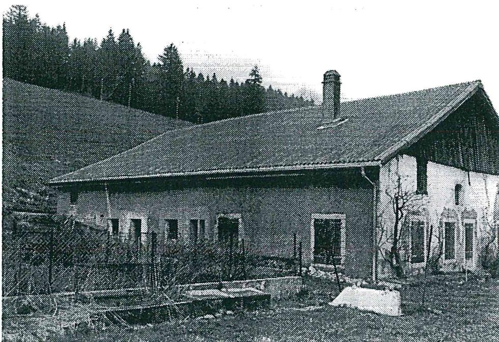
Toiture recouverte de plaques ondulées "Eternit"
