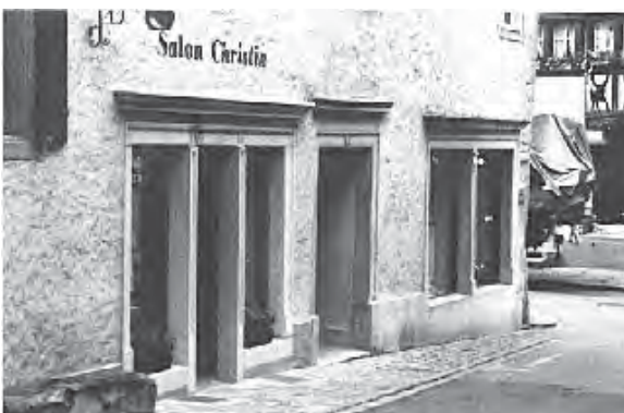
Gut gestalteter neuer Ladeneingang und Schaufenster
