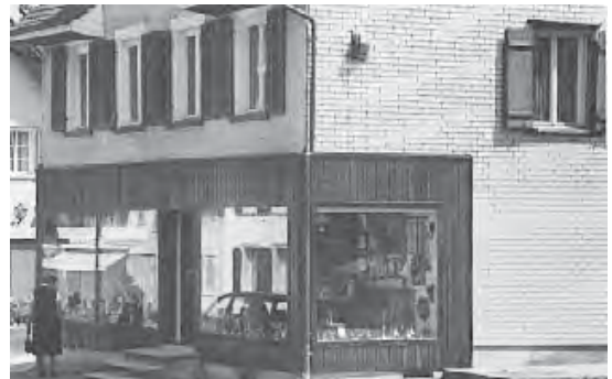
Schlecht: um die Ecke gezogene Fenster lassen das Gebäude optisch schweben. Falsche Materialwahl
