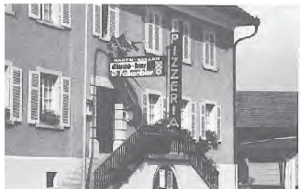
Schlecht: aufdringliche Reklamen verunstalten Haus und Gassenbild
