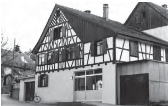
Schlecht: Öffnungen ohne Bezug zur übrigen Fenstereinteilung, falsche Materialwahl für Türe und Anbau
