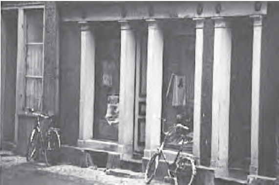
Vorbild: herkömmliche Gestaltung von Schaufenster und Eingang
