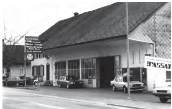
Gut: feinteilige Gestaltung eines Gewerbeeinbaus in ehem. Ökologieteil
