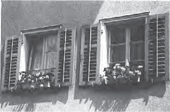
Gut: Fenster mit Sprossen als stehendes Rechteck mit Einfassung und Läden
