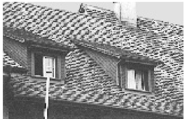
Gut: Schleppgaube schmal und niedrig, Seitenwände im Dachton
